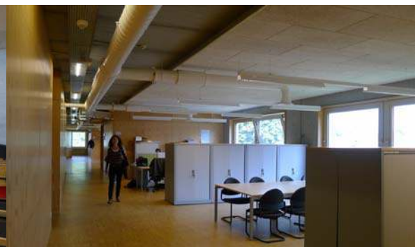
Technieken in het zicht, lesgebouw
