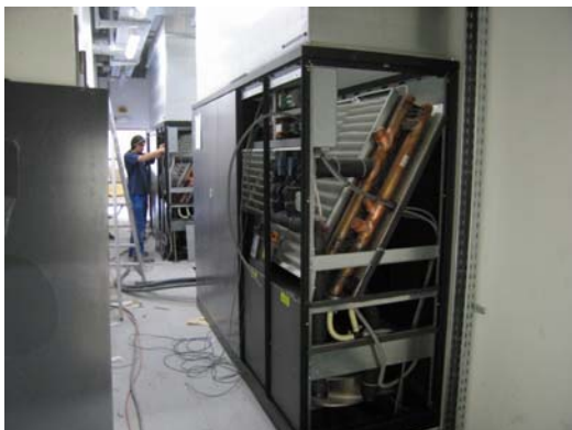
Klimaatkasten in technische gang
