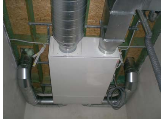
Opstelling luchtgroep aan plafond in bergruimte
